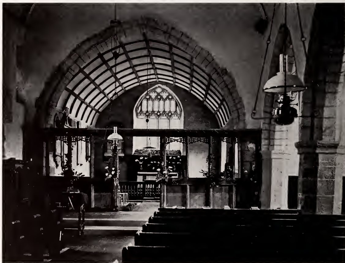
LLANDEFALLE CHURCH, BRECONSHIRE, LLANDEFALLE
